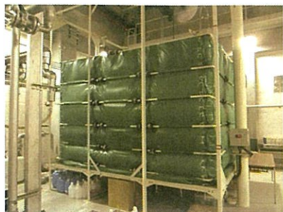
ヘリウムの回収・再液化プロセスに必要なガスバッグは、飛行船設計を出発点としている
